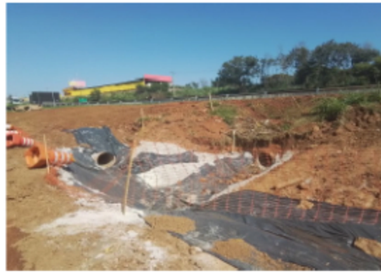
Foto 2 - Canaleta de drenagem
