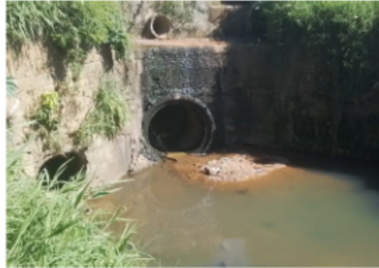
Foto 4 - Vista da montante do tubo Armco.
